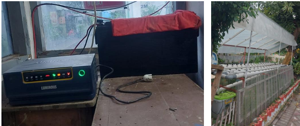
Gambar 1. Unit hidroponik yang didiseminasikan. Dari kiri ke-kanan adalah inverter, baterai dan lubang tanam hidroponik.
